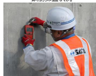
鉄筋探査状況
